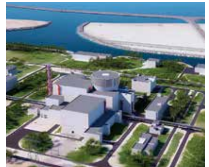
EL DABAA Project
